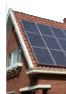
Zonnepanelen/ Capteurs solaires
